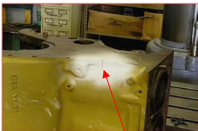
Fissura nos orifícios dos parafusos da tampa.
