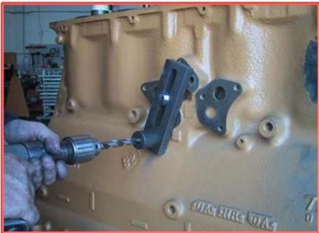
Utiliza-se um fixador adequado para alinhar e centrar a broca para reparar o furo danificado.
