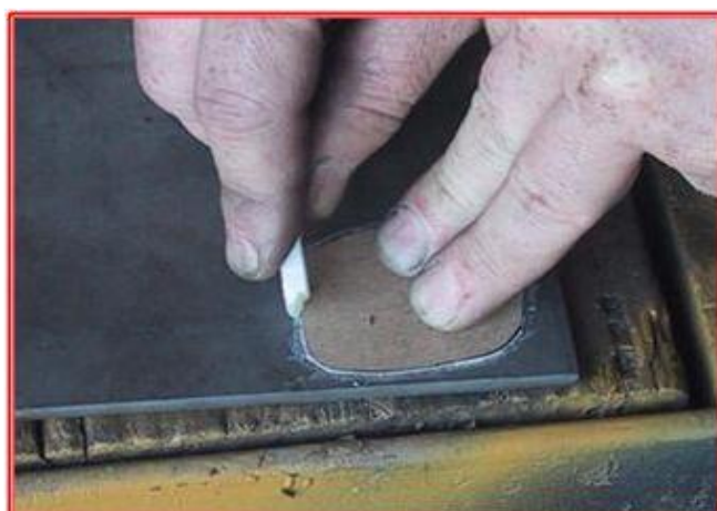
Cortar uma placa de aço da mesma espessura segundo o molde com oxy-acetileno ou plasma.
