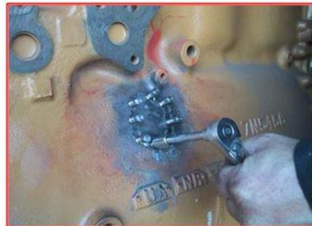
A serie final de pinos é instalada.
