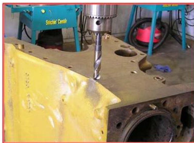
Brocar o furo danificado para instalar o pino roscado, Full-Torque® , tipo FFB.
